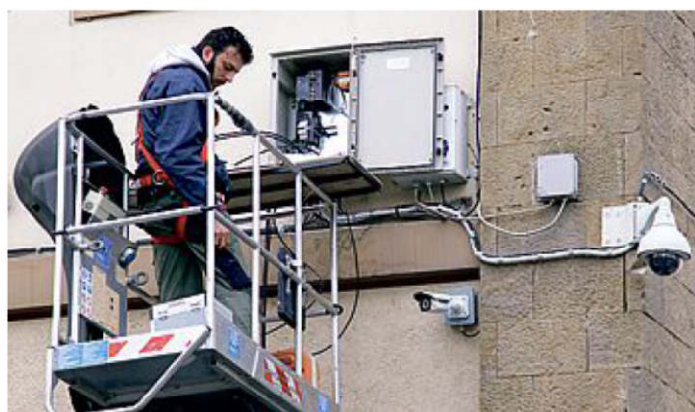
Telecamere per sorvegliare le strade più pericolose e trafficate di Figline
